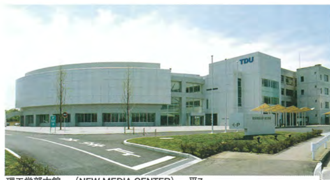
理工学部本館 (NEW MEDIA CENTER) 平7
