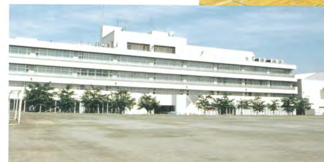
校庭よりの校舎全景 平4.2 竣工
