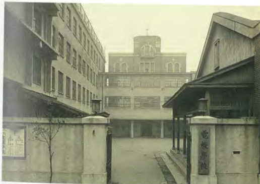
第1期工事(左側鉄筋4階建)を完成した第1校舎(現本館) 昭5-12竣工
