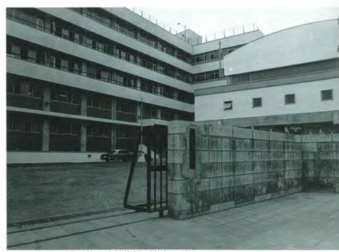
小石川校舎完成に伴い高等学校が移転 昭和40年
