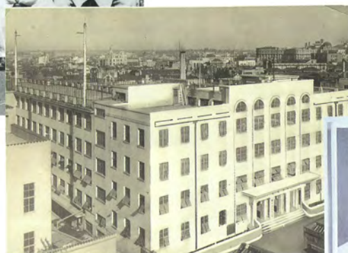
昭和12年完成の第一校舎 昭12.10.16
